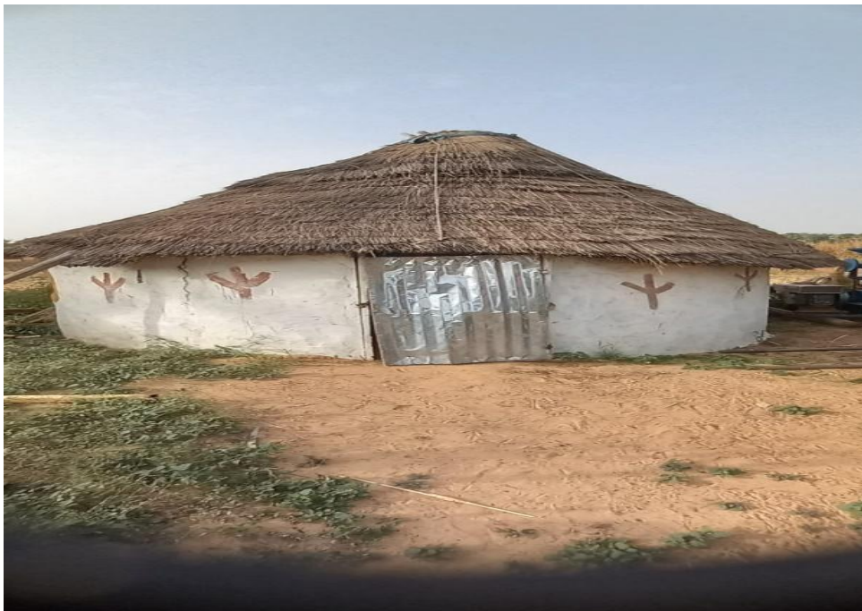
Photo n° 2 : Case en banco de conservation
