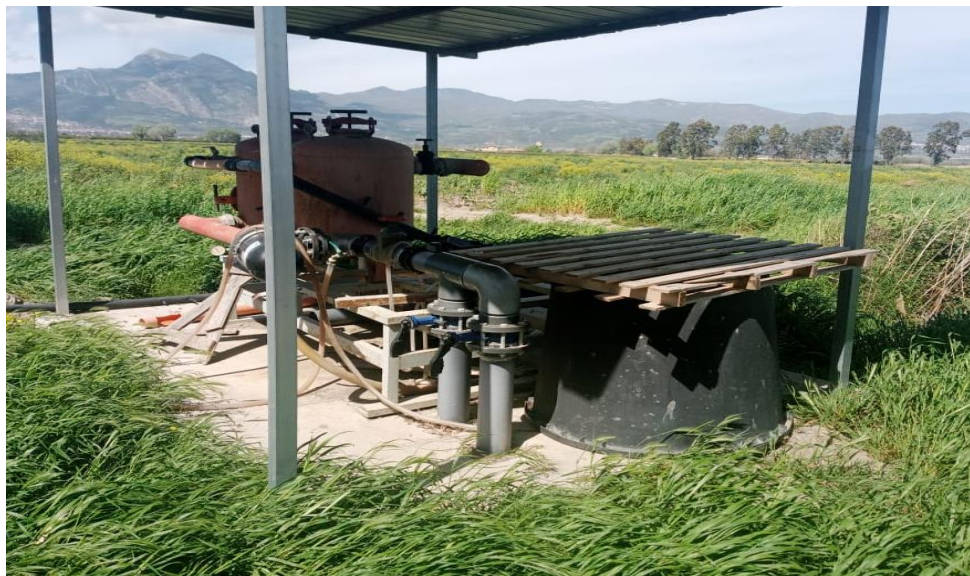
Photo 21 : Une des pompes de la ferme capable d'irriguer la ferme en fertilisants organiques
